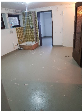
Blick in den Kellereingangs- Bereich, innen Dusche
