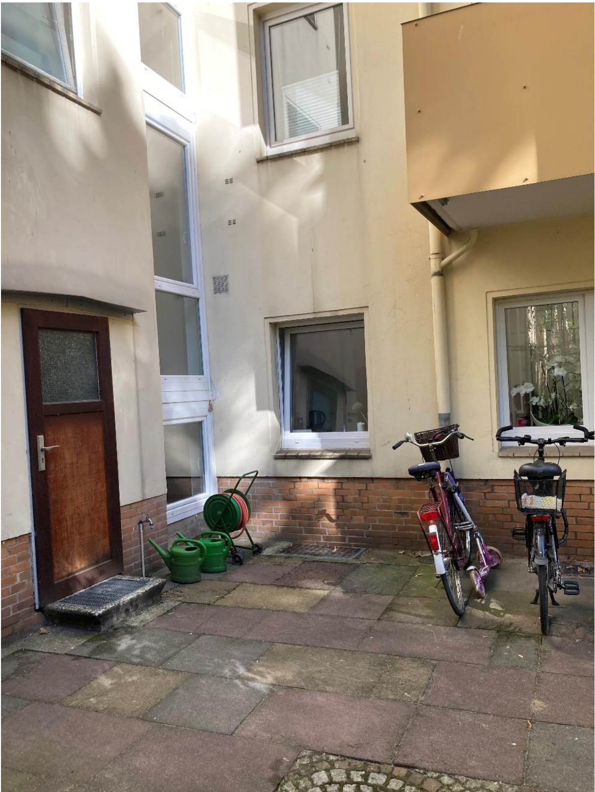
5. Bild: Teilansicht des Innenhofes
