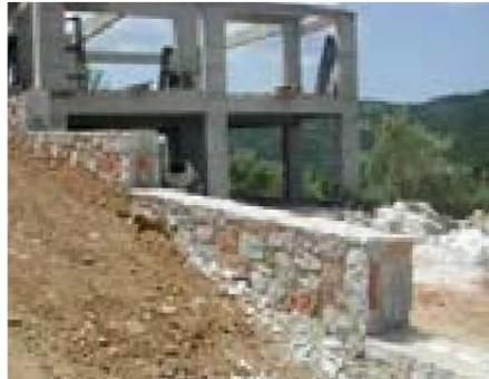
Konstruktion Außen- und Innenwände (Außenwand aus Naturstein 28 cm – Innenwand Ziegel 12 cm und Wärmeisolierung)
